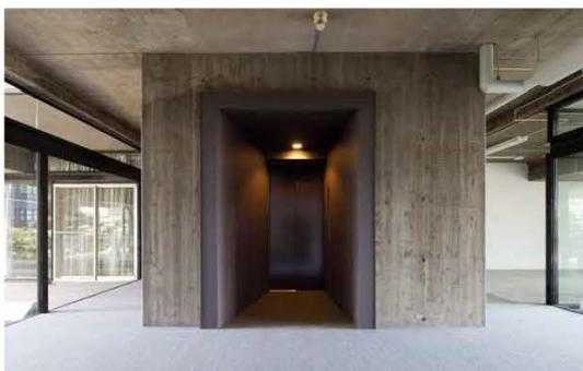
しかし、この補強によってエレベーターシャフト内が狭くなると、既存の大型エレベーターが昇降できなくなります。このエレベーターは博物館時代から使用されていたもので、老朽化が進み、交換用部品も入手困難な状況だったことから、補強にあわせて
